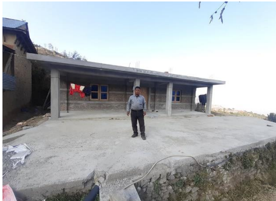
Vor dem neuen erdbebensicheren Haus
