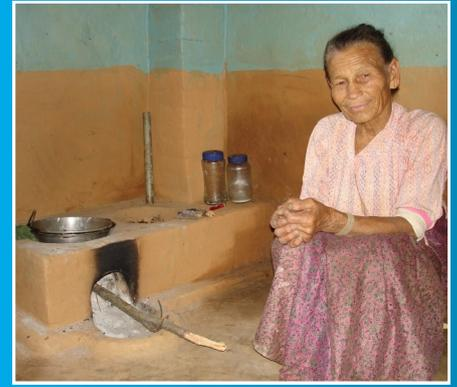
Die Ofenmacher unterstützen im Rahmen des Gold Standard Klimaschutzprojektes in Nepal den Bau von einfachen Lehmöfen durch einheimische Ofenbauer und ersetzen durch sie die traditionellen offenen Kochstellen.
