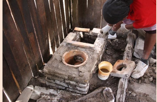
Der Kenia-Ofen im Rohbau – der Ton-Einsatz ist sichtbar
