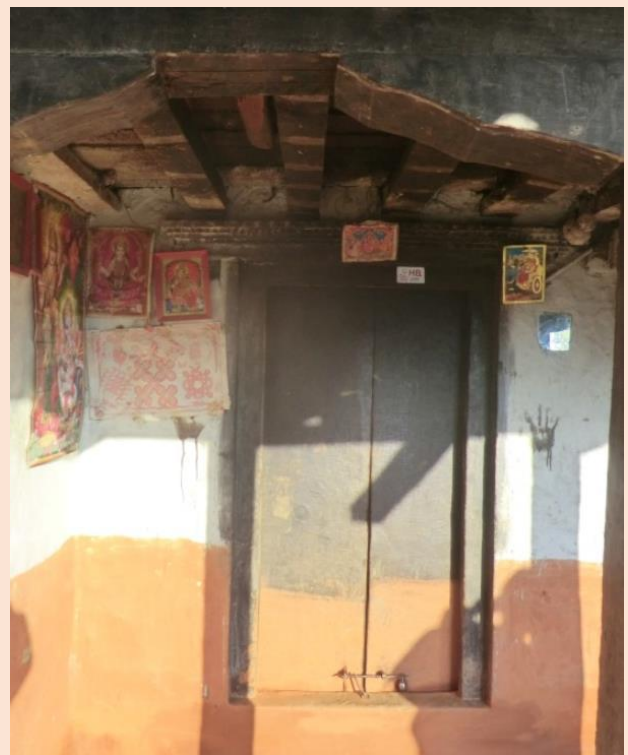
Am Schild an der Tür erkennt man, dass in diesem Haus ein Lehmofen von Swastha Chulo Nepal installiert wurde
