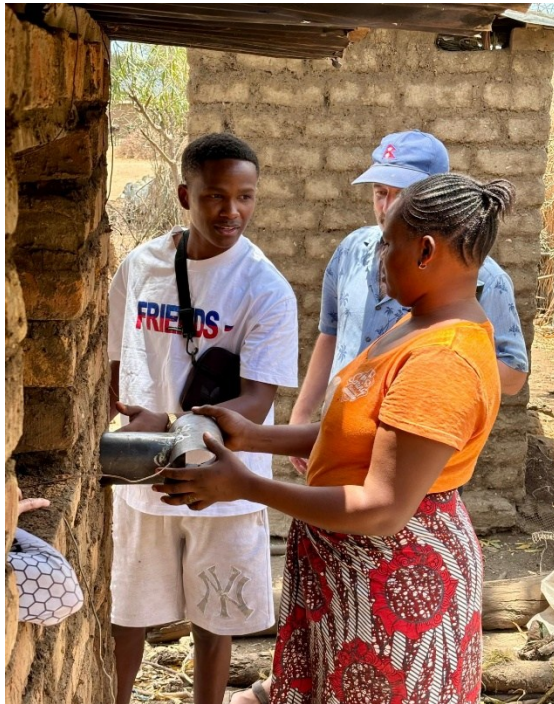
Juma erklärt den Einbau des Outlets
