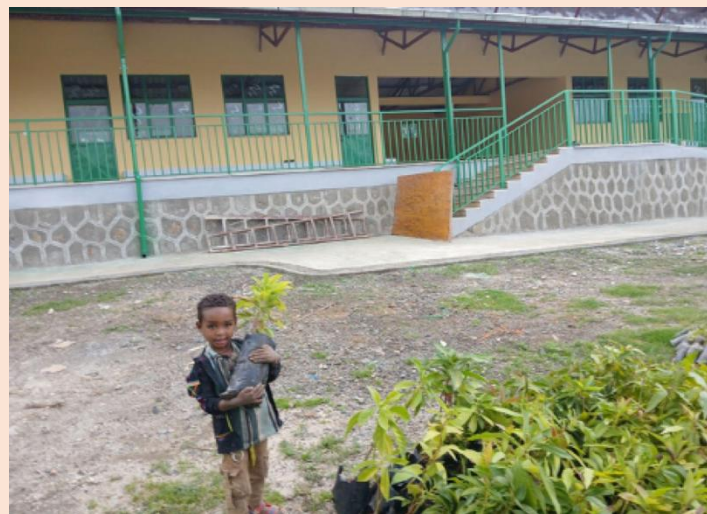
Vor dem neuen Kindergarten - Setzlinge wollen in die Erde
